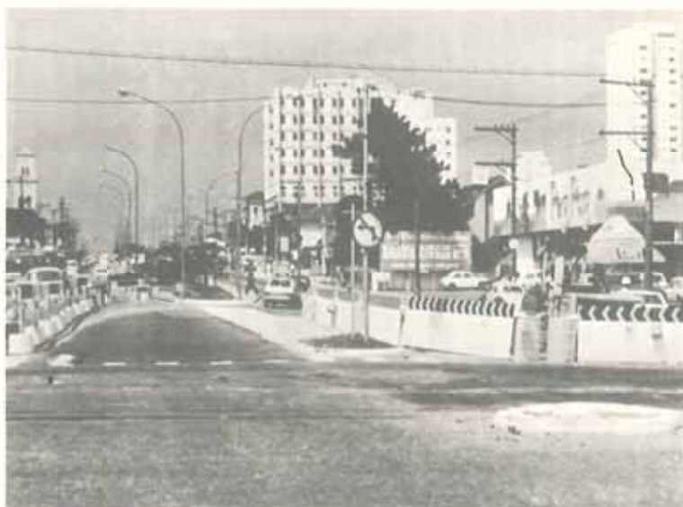
5 — A faixa de transferência provisória, quando usada em desvios, deve ter largura compatível com a capacidade do trecho retilíneo do desvio, de modo a não constituir gargalo. De preferência, deve ser feita com remoção do canteiro e pavimentação.
