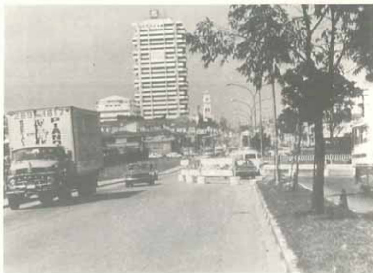
6 — A complementação do tapume nas extremidades do trecho em obras evita conversões indesejáveis e dá um acabamento que demonstra cuidado e responsabilidade. Permite, também, assinalar claramente para os motoristas o término do trecho em obras.
